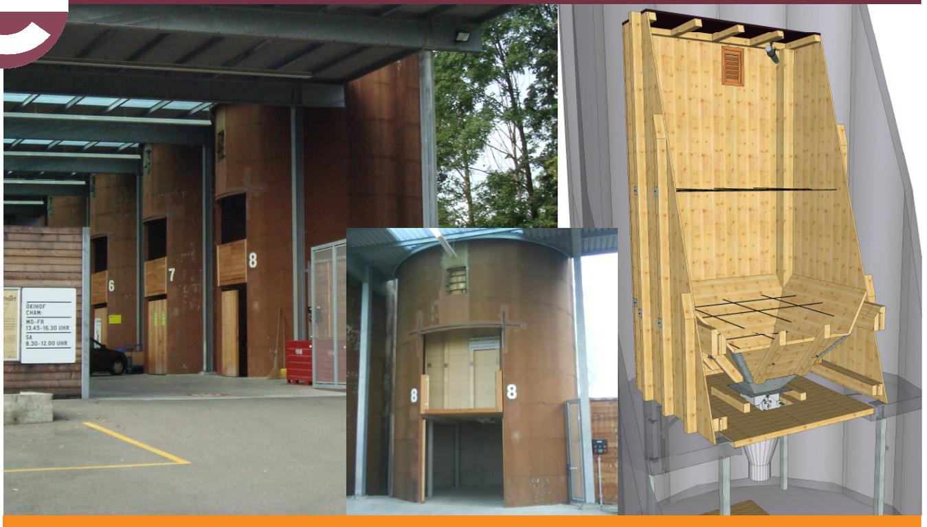
Auf dem Recyclinghof Cham-Furenmatt wurde ein Getreide-Silo einer ehemaligen, unter Heimatschutz stehenden Kälberzucht zu einem Salzsilo umfunktioniert. Das Einbau-Silo wurde auf einem Zwischenboden des ehemaligen Getreide-Silos zusammengesetzt und aufgestellt, sodass an der bestehenden Aussenhülle keine Umbauarbeiten notwendig wurden.
