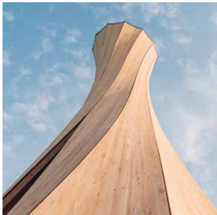
Der Urbach-Turm – hergestellt aus selbstformendem Holz, zu sehen an der Remstal Gartenschau 2019, Urbach. (Bild: ICD/ITKE, Universität Stuttgart)
