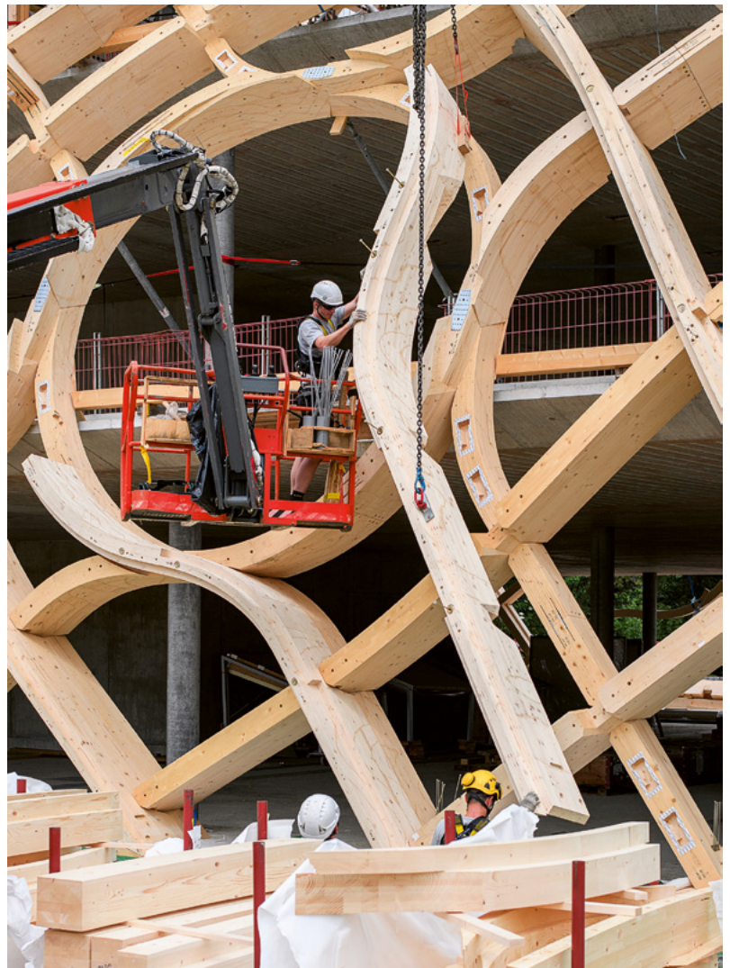
Montageprozess Holzgitterstruktur Bild: Jan Bolomey, Blumer-Lehmann → Youtube-Videos zum Bau auf der Website von Blumer-Lehmann
