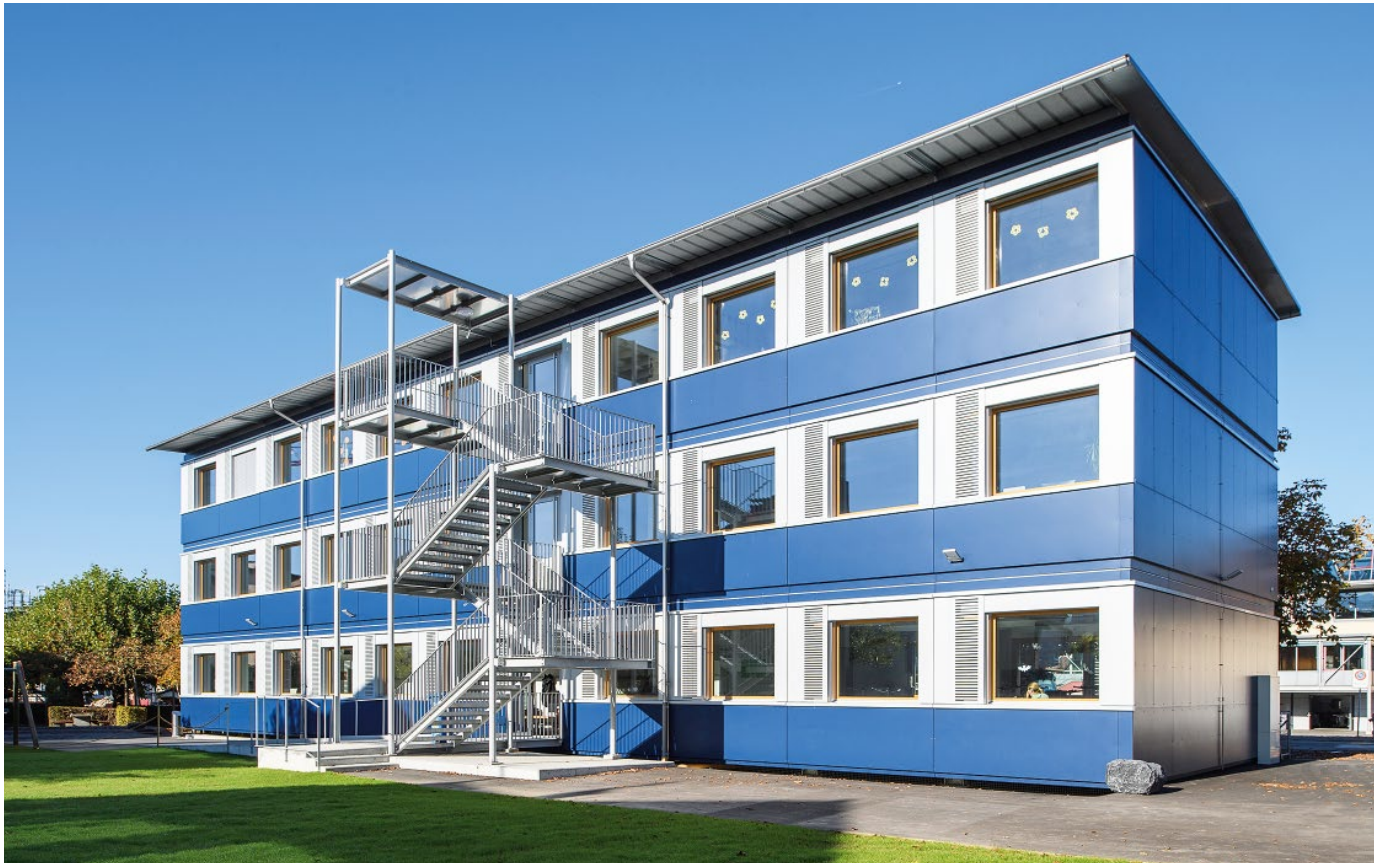
Bild 1. Modulbau für ein Schulprovisorium in Baar/Schweiz: Neben der kurzen Planungs- und Bauzeit zeichnen sich Modulbauten durch ihre Kostensicherheit, Ausführungsqualität und Flexibilität aus
