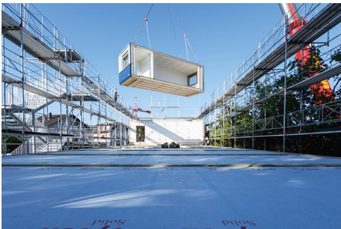
Bild 3. Vor Ort platziert und installiert das Montageteam die Module präzise an der geplanten Position; hier erfolgen nur noch die Fertigstellungsarbeiten (Fotos: Blumer-Lehmann)
