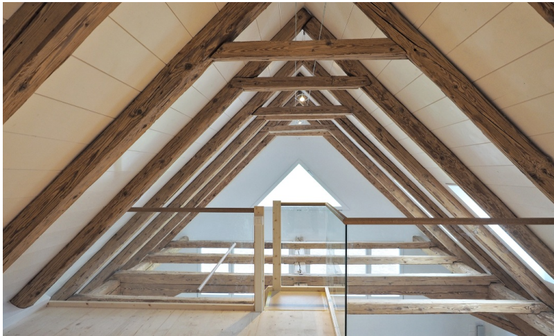
Dachstuhl saniert und ausgebaut
