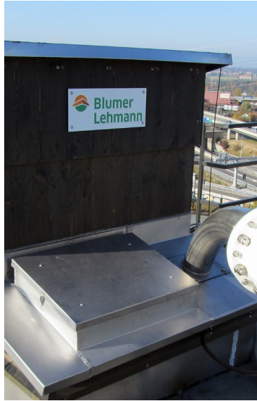
Streugut-Siloanlage mit Streufahrzeuge in Bern Wankdorf
