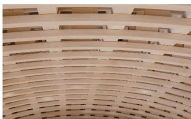
En collaboration avec ses partenaires d'ingénierie et de géométrie, Blumer Lehmann a conçu la structure porteuse du toit hautement élaborée et s'est chargé de la planification et de la production des éléments de construction, ainsi que du montage.
