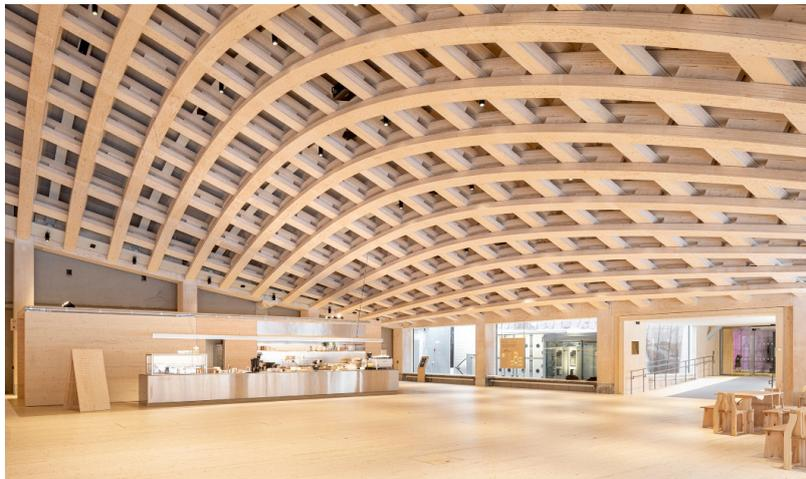
Le toit à formes libres, sans piliers, doté d'une construction en coque grillagée visible composée de bois LVL, couvre une surface de 25 x 48 mètres.
